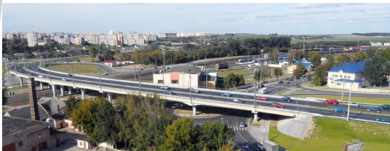
Трехуровневая транспортная развязка на пересечении проспектов Жукова и Дзержинского в г. Минске, длиной 458,3 м, на 375 буронабивных сваях. При устройстве 17 пролетов эстакады использовано 272 железобетонные балки длиной от 18 до 33 м (2012 г.)
