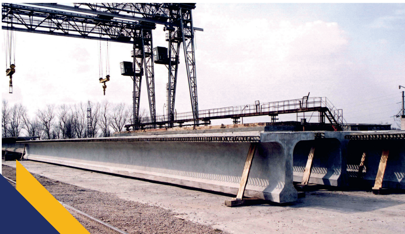
Полигон по изготовлению балок длиной 33 м
