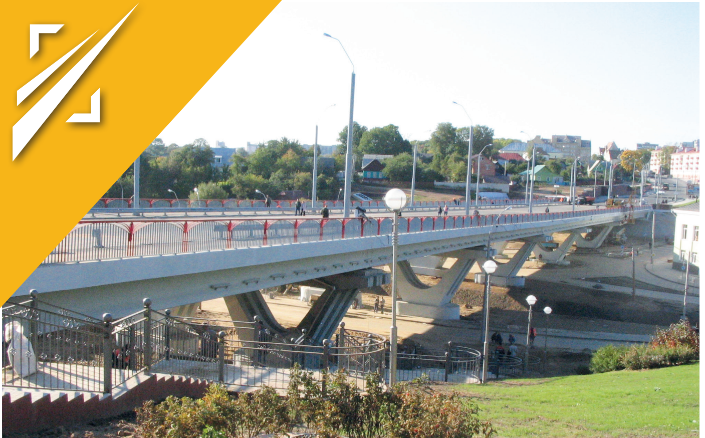
Мост через реку Дубровенка в Могилеве
