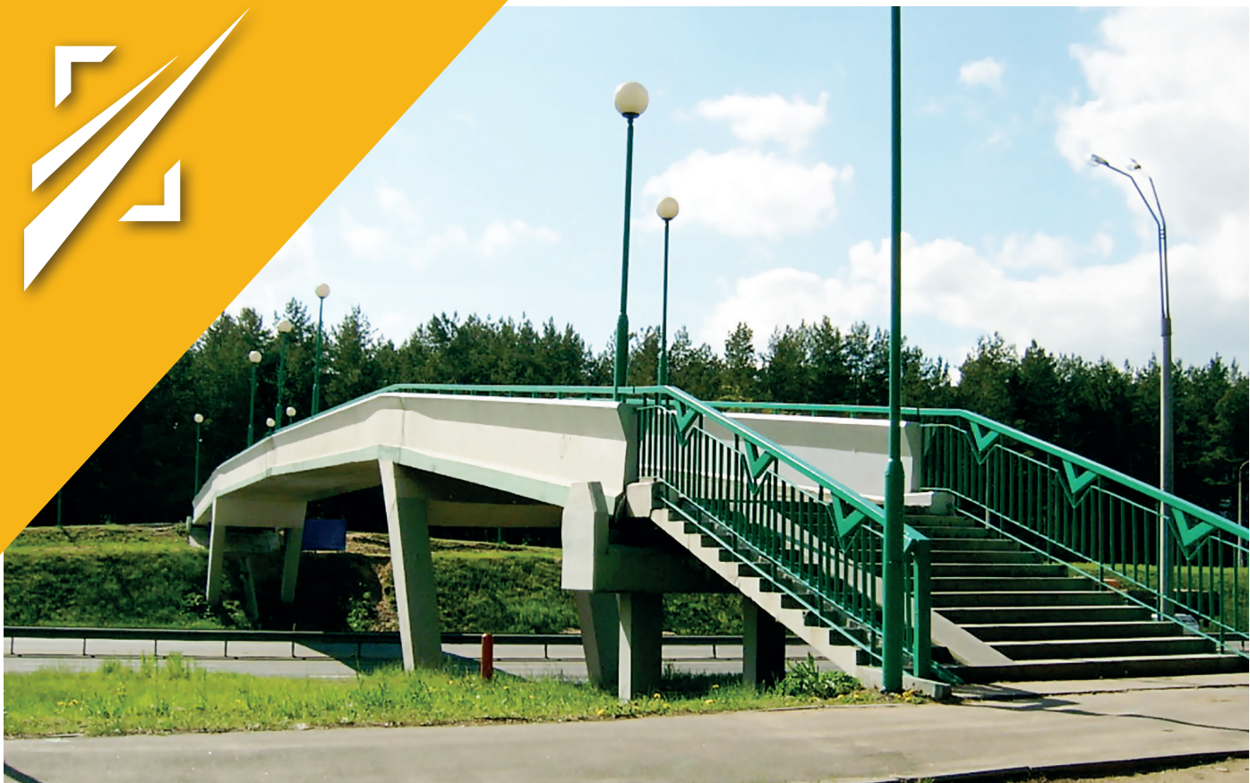
Пешеходный переход через автомобильную дорогу
